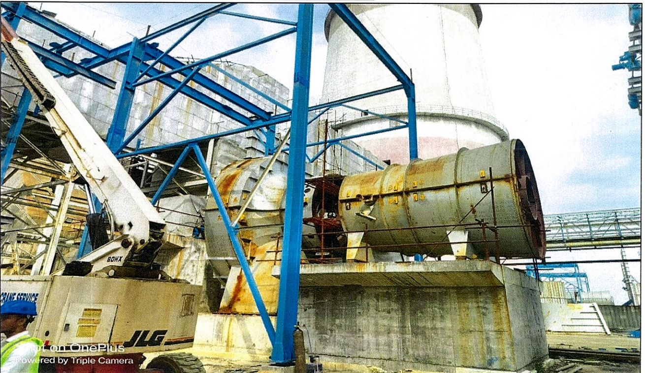
Booster fan erection
